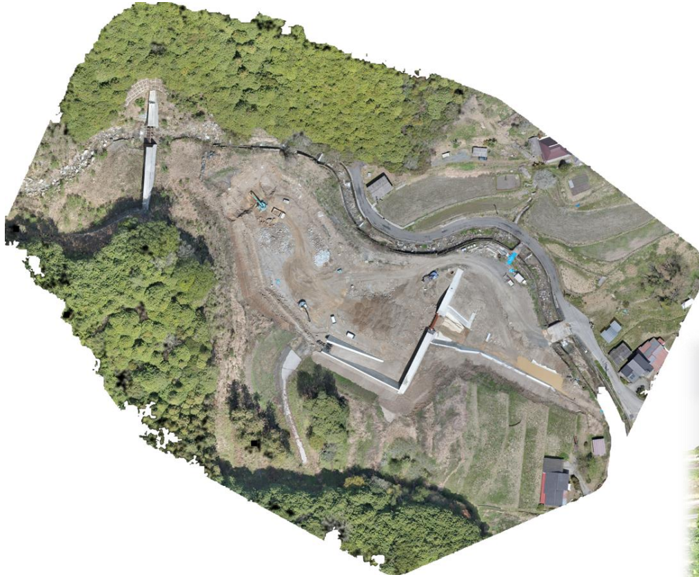
砂防の工事現場
