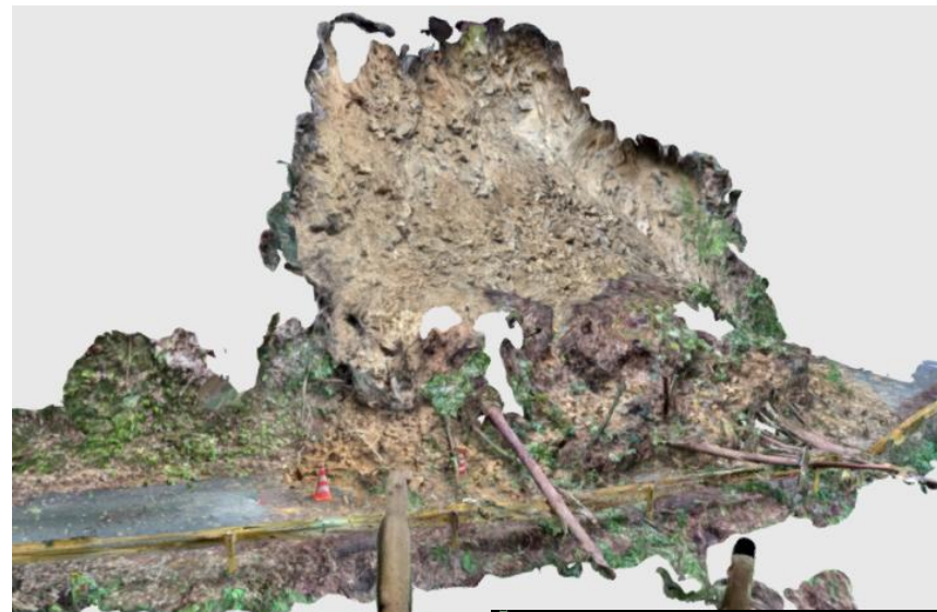
道路の崩落現場
